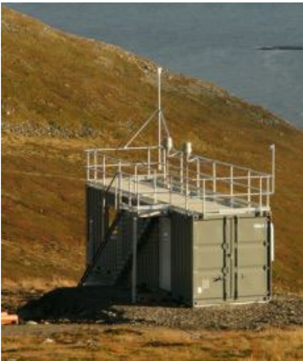
Figure 3 : Station de surveillance atmosphérique
